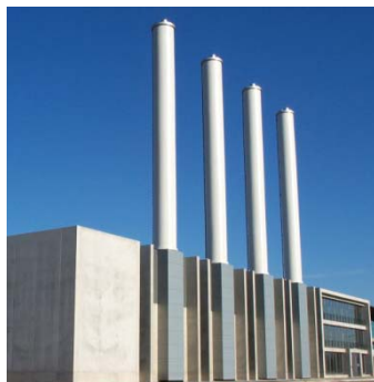
Energiezentrale Kirchberg Centrale d'énergie Kirchberg
