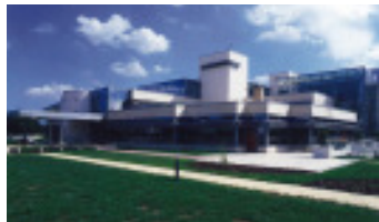
Pflegeheim Bettemburg Maison des soins Bettembourg
