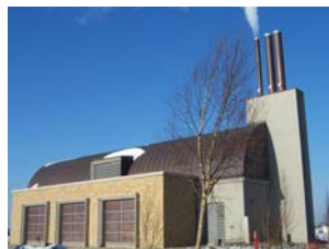
Energiezentrale Hesperange Centrale d'énergie Hesperange
