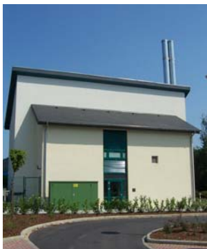
Energiezentrale Lintgen Centrale d'énergie Lintgen
